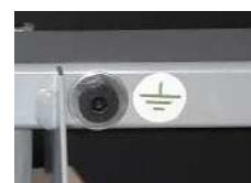
Punto de conexión estructura a la toma de tierra para evitar la acumulación de carga electrostática y el campo magnético que pueda generar, en prevención de Lipoatrofia Semicircular
